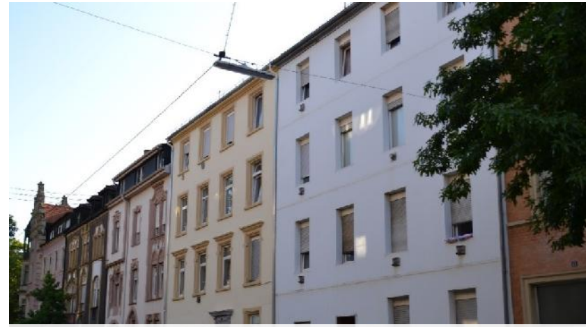
Aufeinandertreffen unterschiedlicher Fassadengestaltungen
