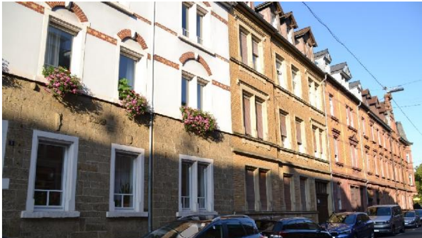
Historische Bausubstanz mit energetischen Mängeln / teilweise fehlende zeitgemäße Dämmstandards
